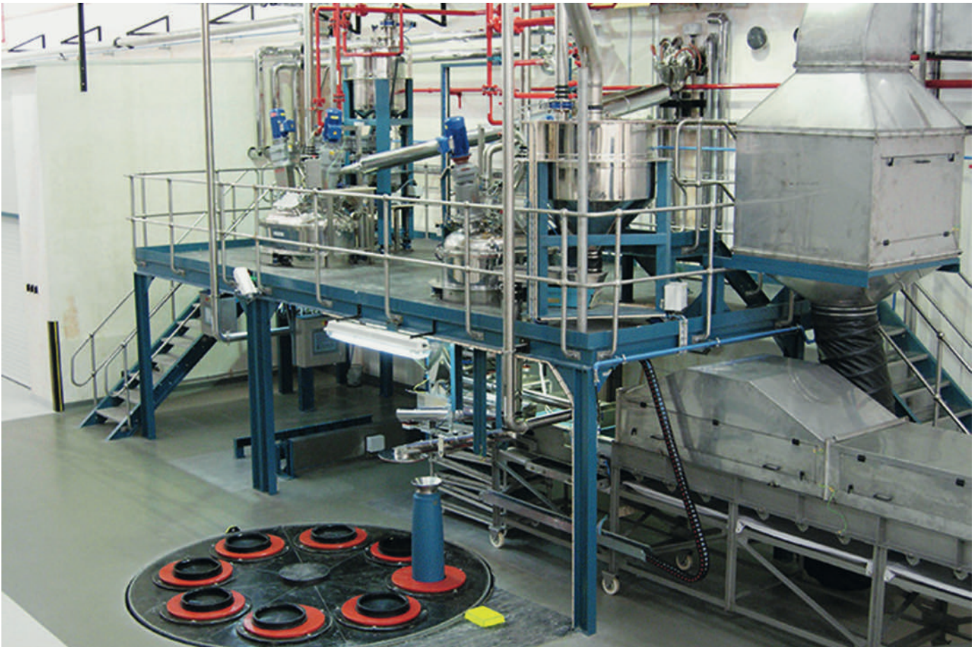
Une halle de démontage/recyclage de munitions. Certains composants sont ainsi réutilisés.
